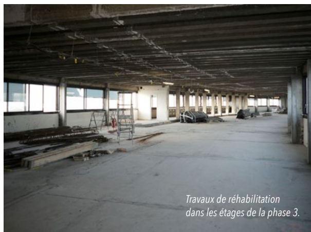
Travaux d'aménagement dans les secteurs 4 et 5.
